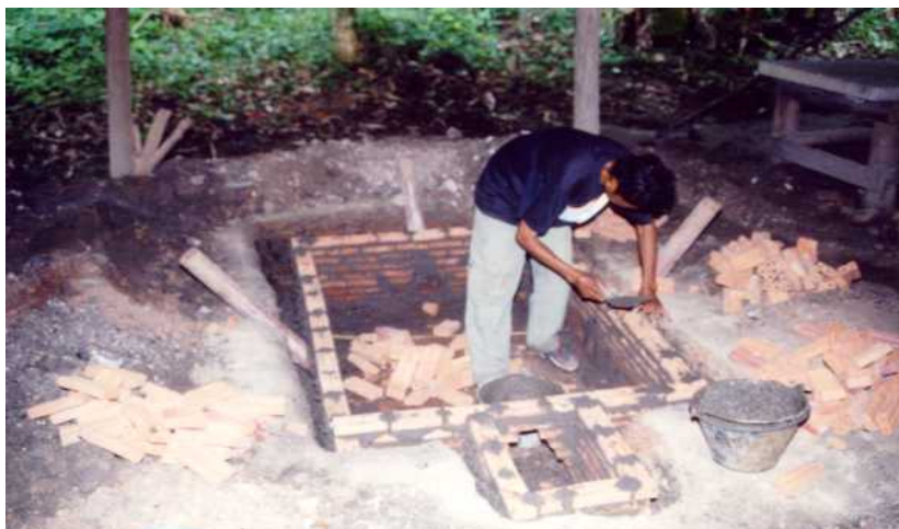
ภาพที่ 1.1 การสร้างเตาหลุมฝังกรมป่าไม้
