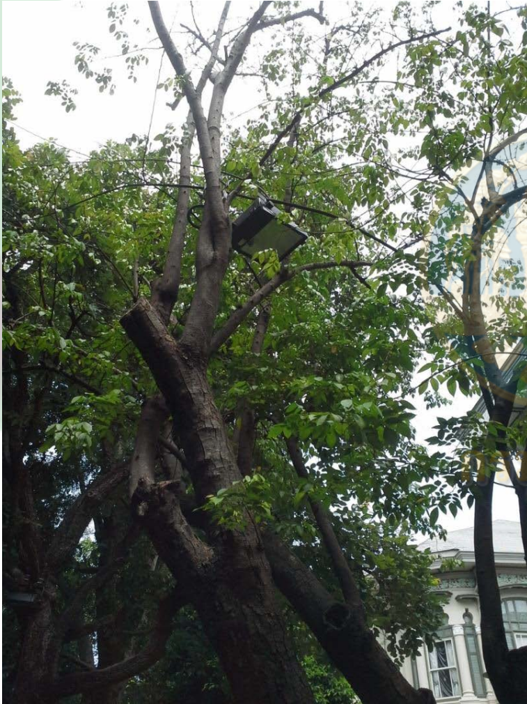
การติดตั้งโคมไฟที่กิ่ง
