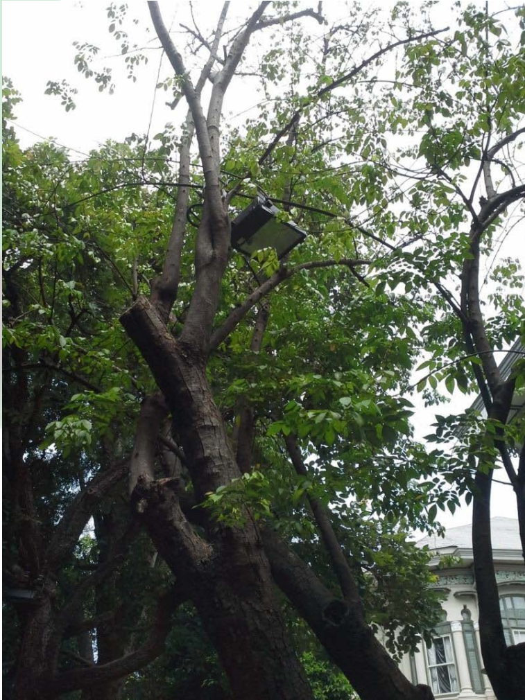
การติดตั้งคอมไฟที่กิ่ง
