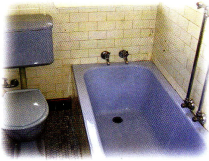
สำรวจช่องว่างใต้อ่างอาบน้ำ และอ่าง ล้างหน้า
