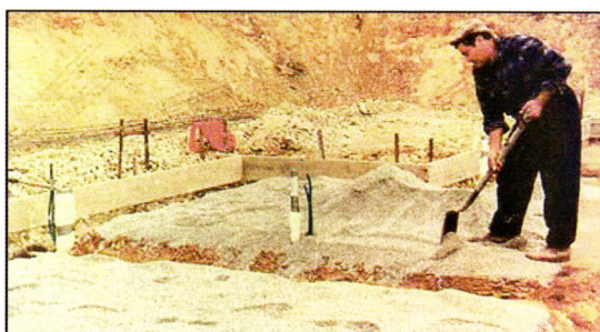
การป้องกันโดยการใช้หินหรือกรวดก้อนเล็กๆ
