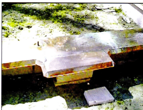
การใช้แผ่นโลหะกันแนวทางเดินของปลวก
