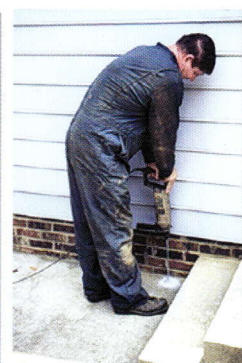
การใช้สว่านเจาะพื้น คอนกรีต เพื่ออัดน้ำยา
