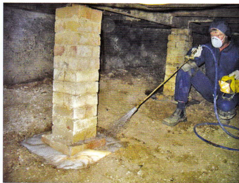
ฉีดพ่นน้ำยาบริเวณรอบโคนเสา
