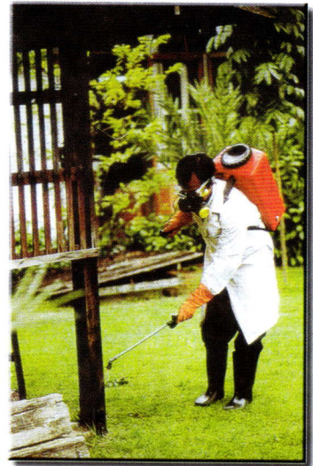
การฉีดพ่นสารเคมีเคลือบบนผิวดินและผิวไม้
