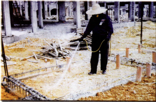
การฉีดพ่นสารเคมีเคลือบบนผิวดินและผิวไม้
