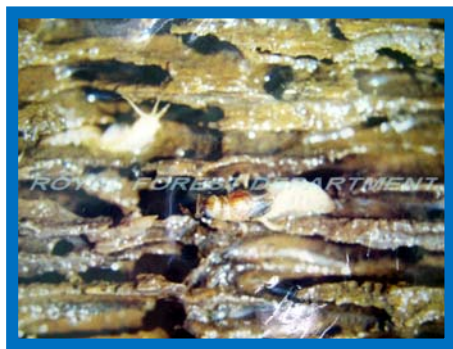
ไม้ที่ถูกเพรียงน้ำจืดทำลาย
